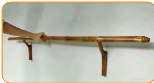
ภาพราวจับบริเวณบันไดและวัสดุทางเลือก
